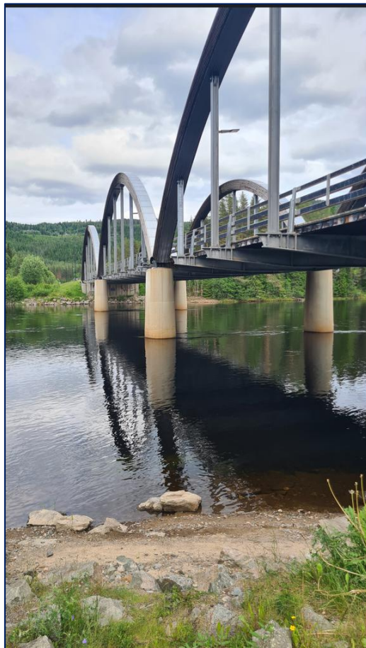
Figur 5-4: Bildet fra Bruen nedstrøms planområdet. Bilde tatt av Trysil Entreprenør AS
