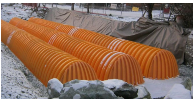
Figur 13 Overvannsmagasin under installasjon, her vist Stormtech
