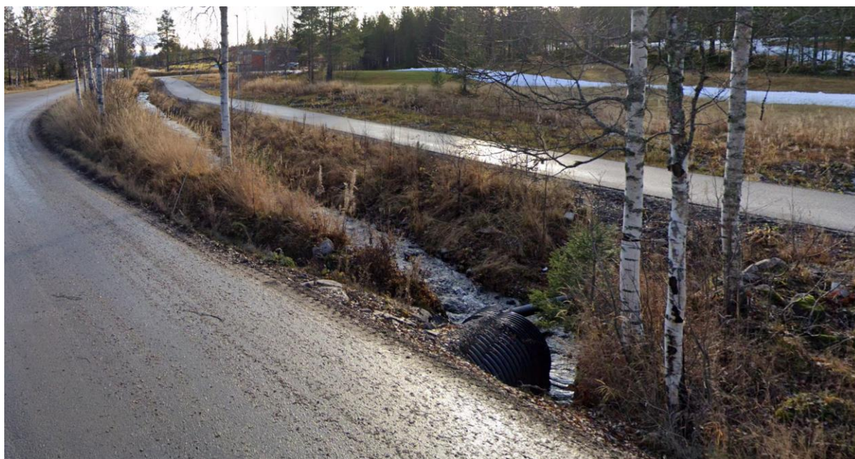
Figur 7: Bilde av stikkrenne ved adkomstvegen før bekken når sykkelparken. Foto: Google maps
