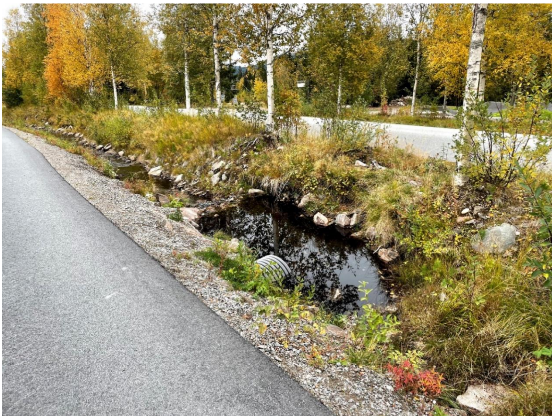
Figur 6: Bilde av utløpet av stikkrenne sør for snølageret sett mot adkomstveg og sykkelparken.
