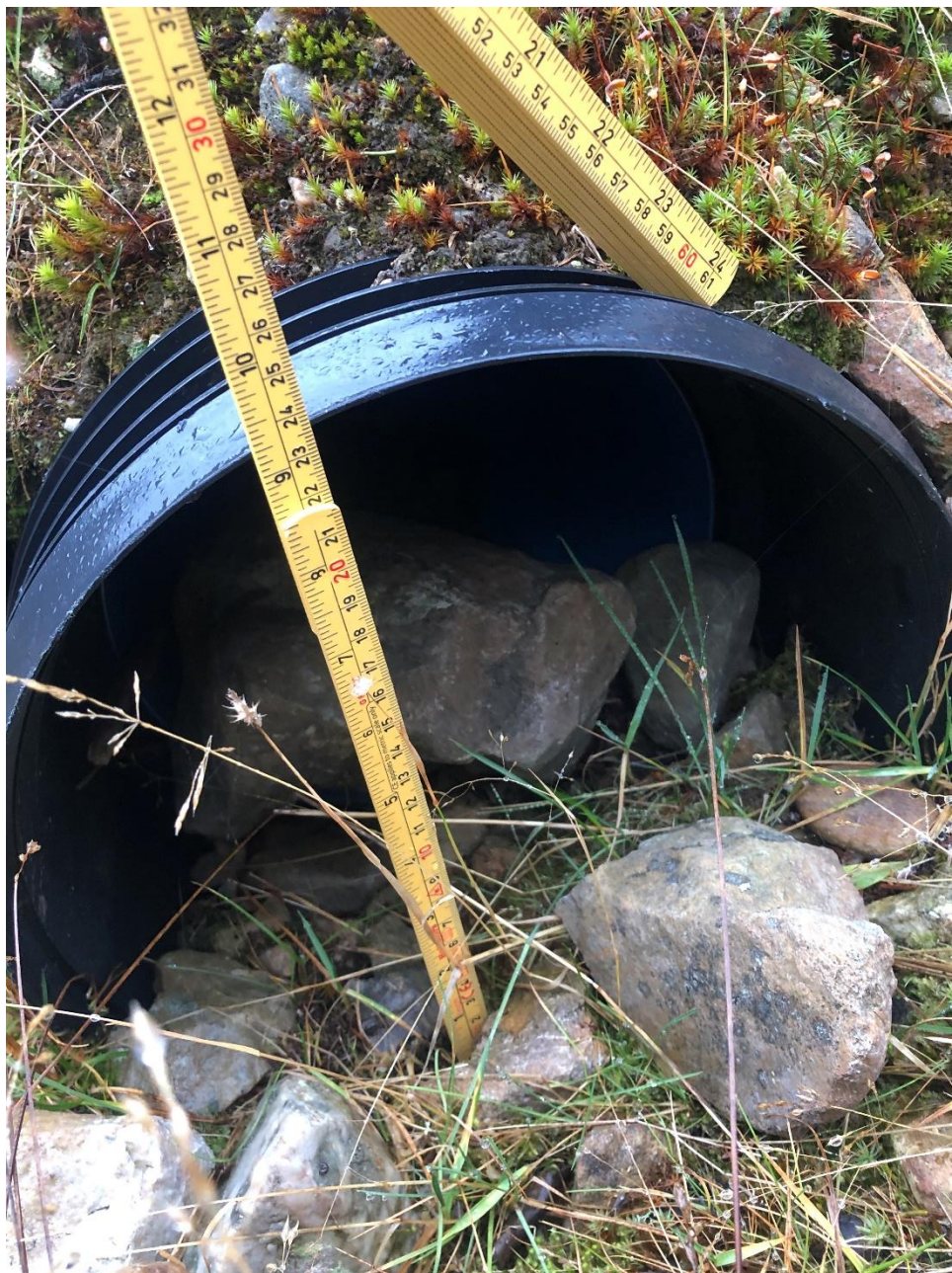
Figur 2: Stikkrenne med delvis gjenfylt åpning ved eksisterende turveg.
