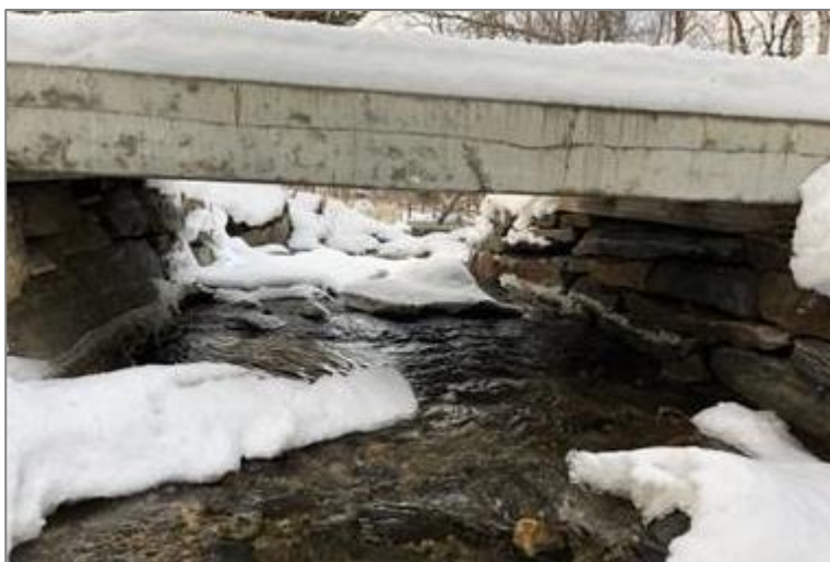
Figur 10. Eksempel bilde for etablert platebru i kryssing av en eller flere bekk
