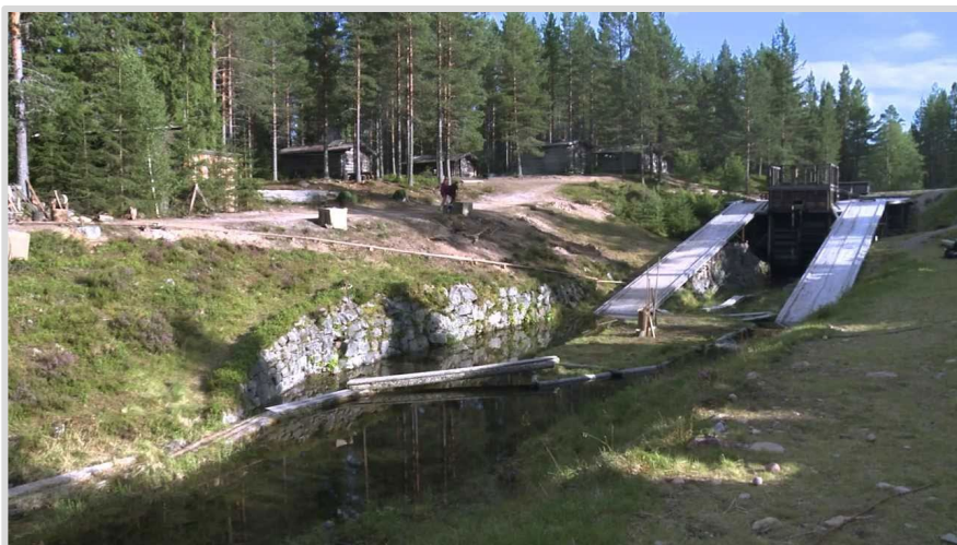
Figur 6.9: Bildet viser Støa kanal i dag. Anlegget er restaurert og fungerer som museum. Foto: kanalspillet.no
