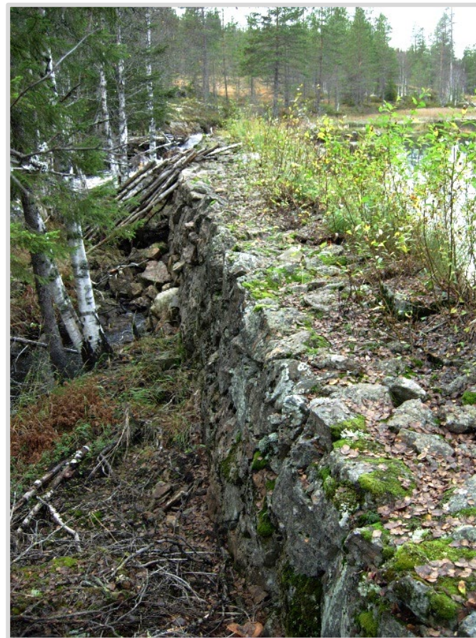
Figur 6.8: En av armene til dammen, oppmurt i naturstein. Foto: Bo Hansson
