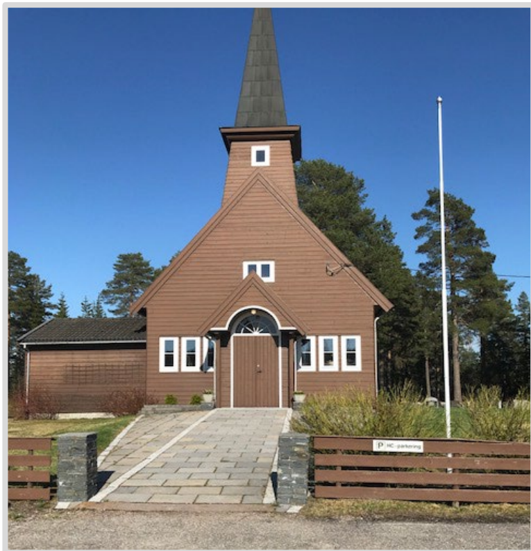
Figur 3.3: Universelt utformet inngangsparti ved Tørberget kirke i Trysil. Foto: Ole Martin Norderhaug.
