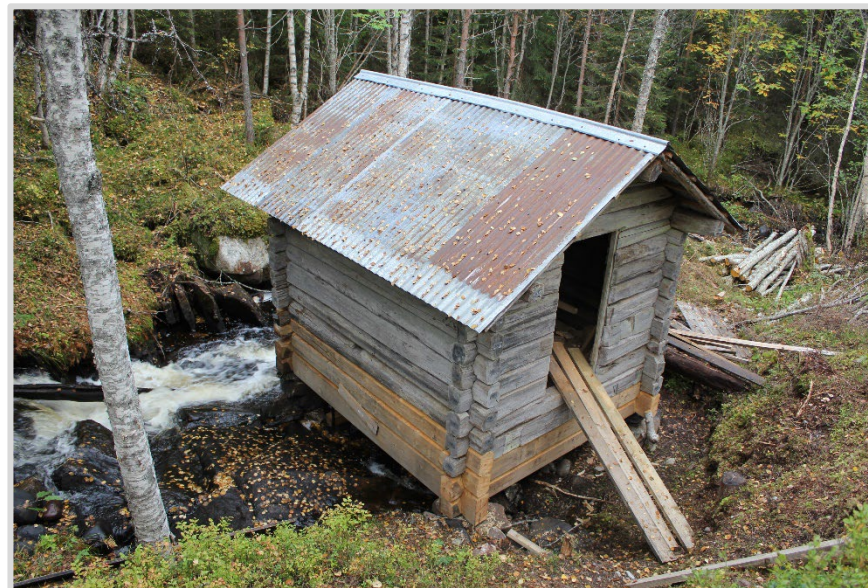
Figur 11.4: Kverna i Styggbekken under restaurering høsten 2017
